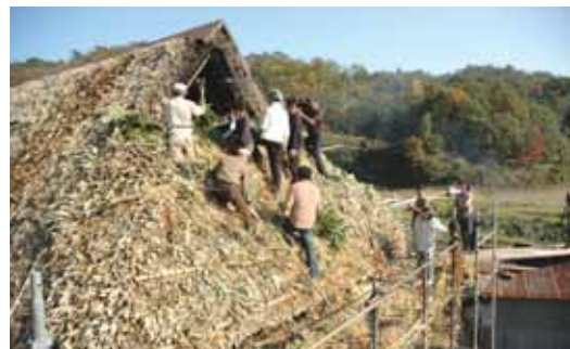
ふき替え作業中
