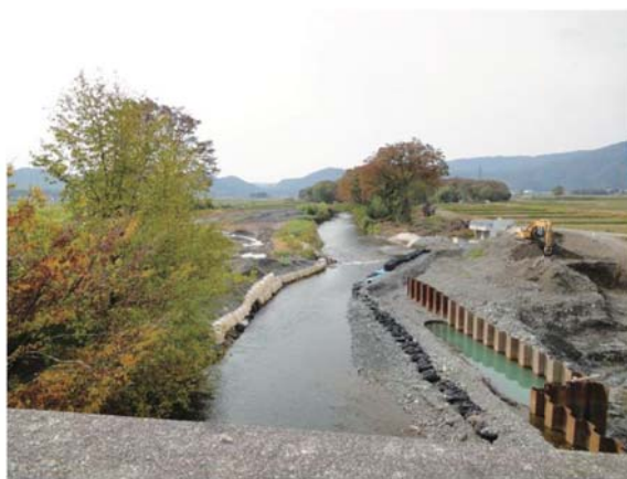
写真2 河畔林の下流で行われている河川改修 (高島市 石田川)
