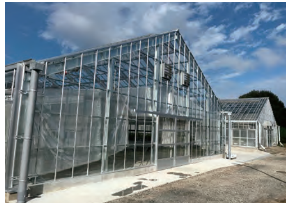
図1 環境制御装置を備えたガラス温室
