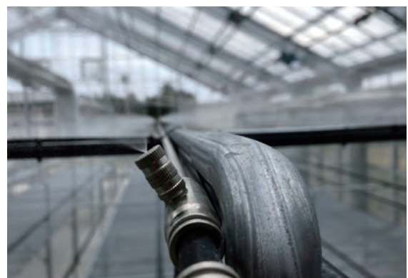
図2 環境制御装置の1つである細霧冷房装置
