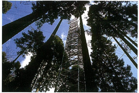
写真-1 鹿北試験流域に建設された気象観測鉄塔：高さ50mは森林に建設されたものでは国内最大級である
