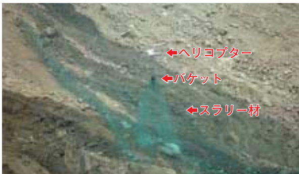
写真-3 ヘリコプターによるスラリー材の散布 （写真提供：長崎森林管理署）
