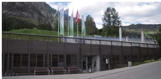
写真-1 会場のアルプバハコングレスセンター
