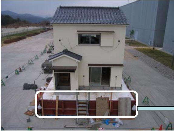
発泡系プラスチック材料の上に建つ試験体
