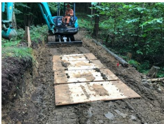
図3 施工試験の様子(林業機械化センター)
