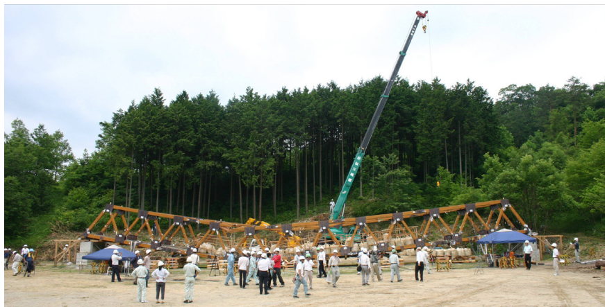
写真2 土嚢積載により破壊した木造単純トラス橋
