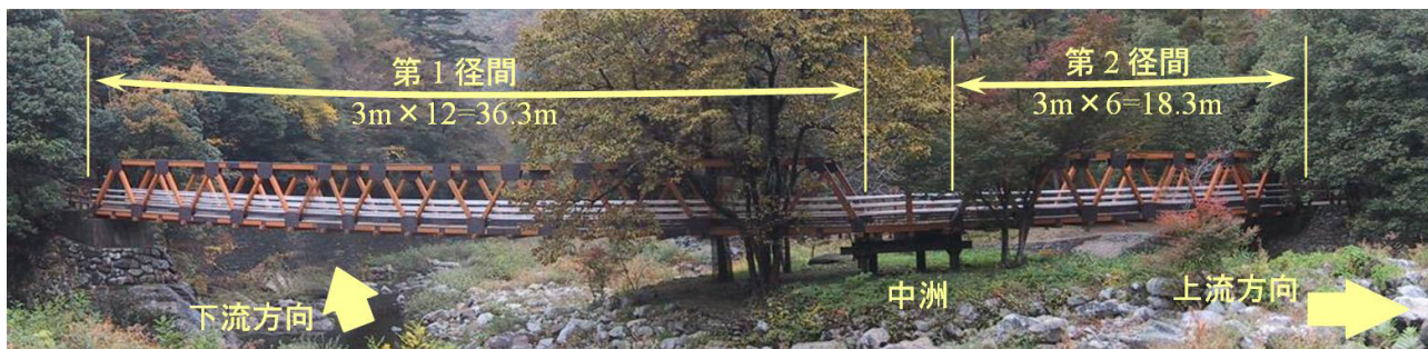
写真1 解体前の木橋 (2003/11/06 撮影)
