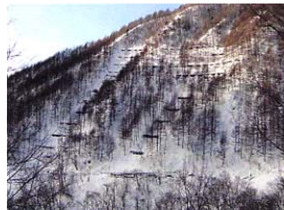
雪崩防止林 成林が困難な場所には雪崩防止柵が設置されている。下方に道路の一部が見える。
