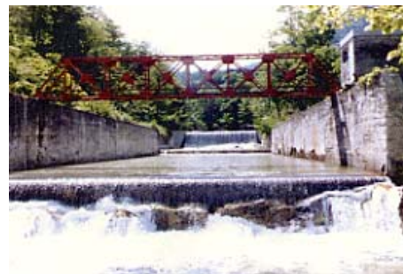
写真 約19km 2 の広さの森林から流出する流量を1938年より65年間観測し続けている量水観測施設（森林総合研究所宝川森林理水試験地本流域）
