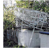
倒壊した観測タワーと下敷きになった観測筒
