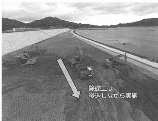
写真3. 除礫工の施工状況とその後の人力での整地の様子(高田松原、撮影:株式会社佐武建設)
