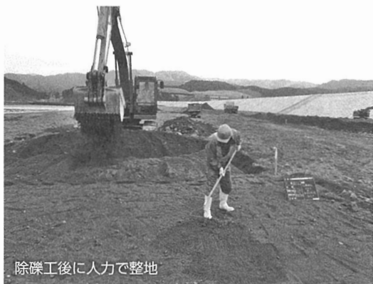
写真3. 除礫工の施工状況とその後の人力での整地の様子(高田松原、撮影:株式会社佐武建設)
