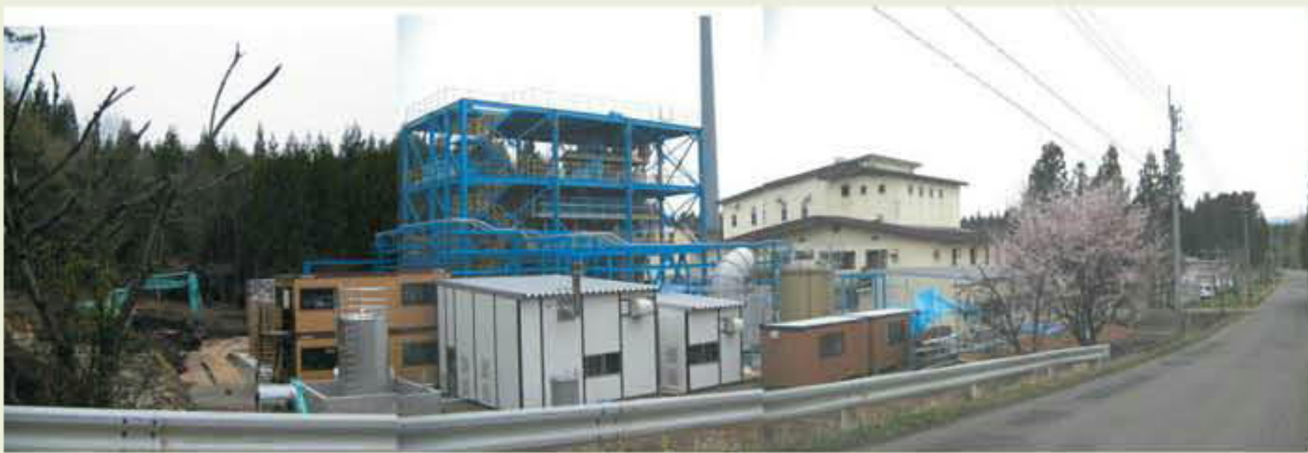
図1 建設中の木質バイオエタノール製造プラント（4月25日現在） 中央の3層架台にバイオエタノール製造機器が置かれる。手前のプレハブは、ボイラー室、コンプレッサー室、仮設作業小屋など、中央右の煙突と左の建物はクリーンエネルギーセンター。 （木村化工機（株）提供）
