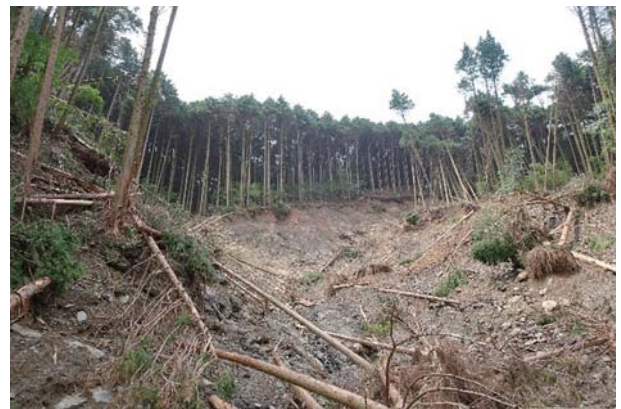
写真3 間伐実施箇所の状況
