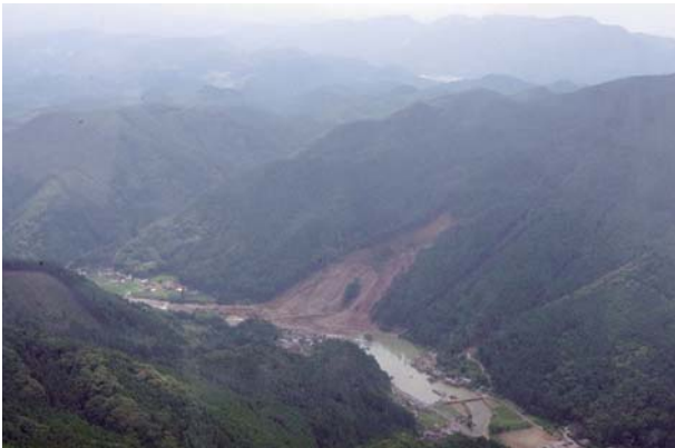
写真2 大分県日田市で発生した崩壊地
