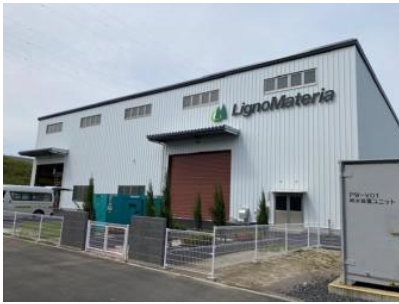
写真1 プラント外観
