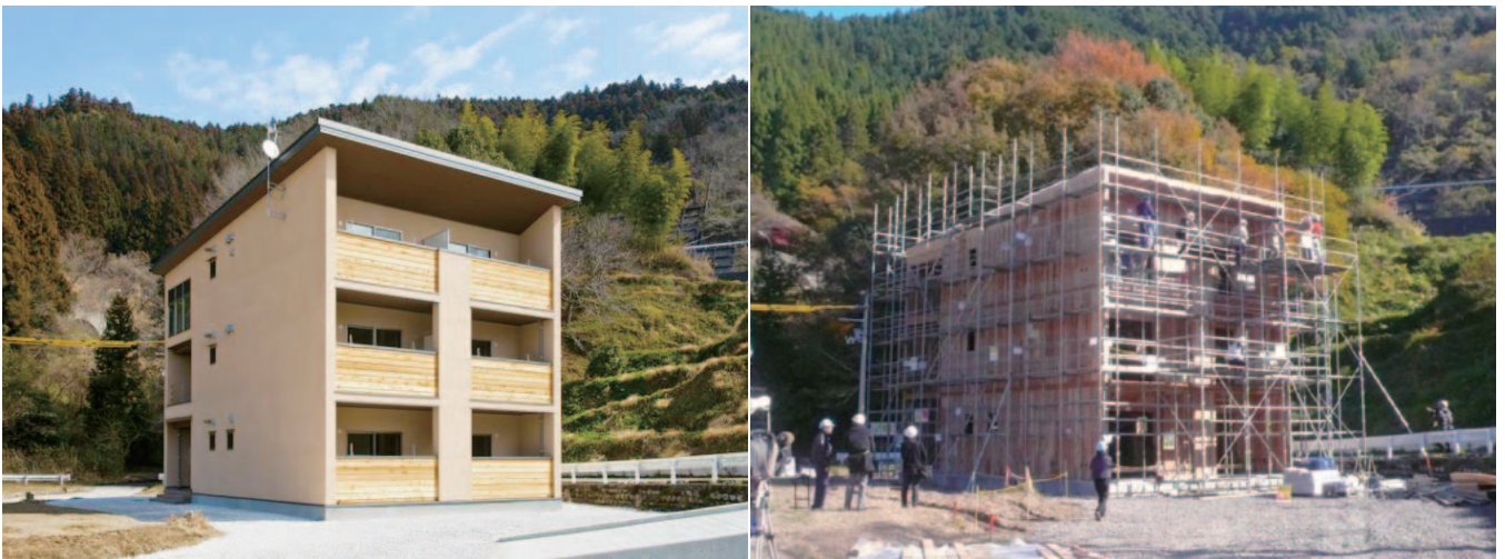
図3 CLTにより建設された共同住宅 左：完成した建物（提供：日本CLT協会） 右：建設中の建物
