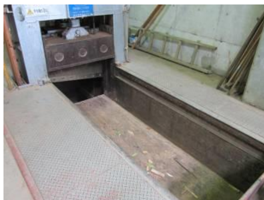
粗大ごみ用ギロチン式切断機
